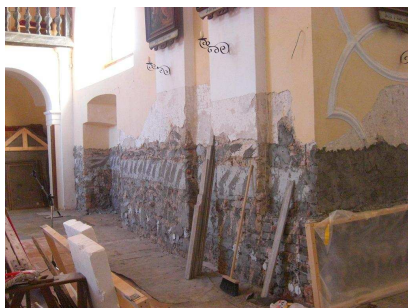
postup prací v hlavní lodi
